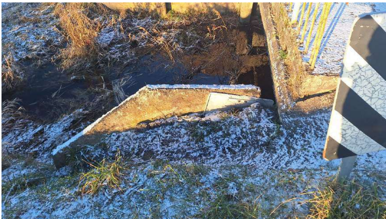
Pav. 6. Pažeidimai atraminiuose guoliuose ir krantinėse atramose
