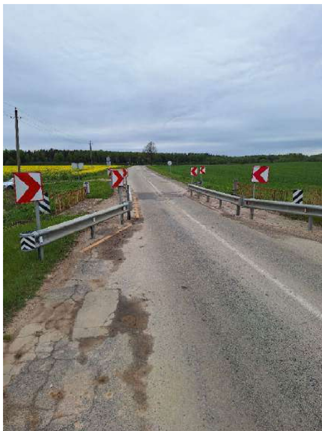
Pav. 7. Defektai tilto prieigose ir liauni bei išsiklaipę turėklai
