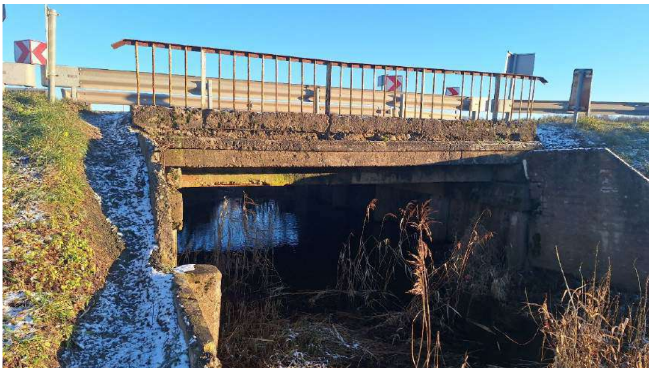
Pav. 4. Tilto fasadas, surūdiję ir per žemi turėklai ir pažeidimai betono konstrukcijoje
