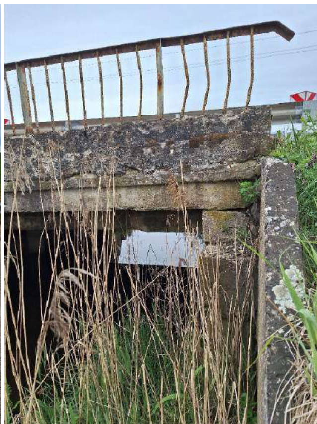
Pav. 7. Defektai tilto prieigose ir liauni bei išsiklaipę turėklai
